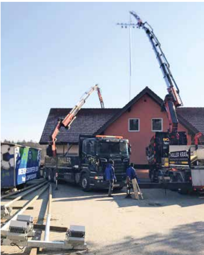
Einsatz von schwerem Gerät bei der Montage der Flutlichtanlage
