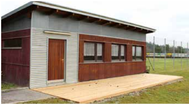
Terrassenboden Eislaufplatz Dietersdorf
