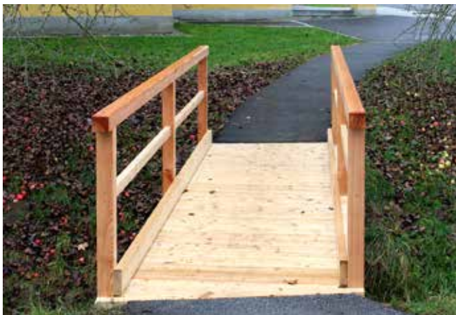
Holzbrücke in Stein
