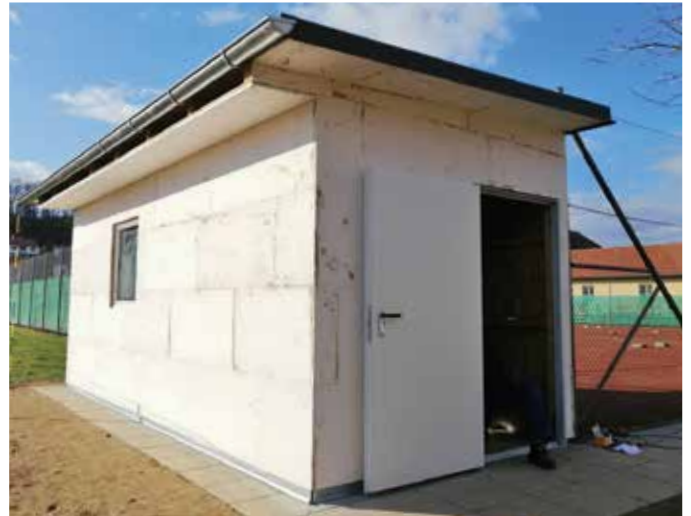
Die neue ATV-Hütte erstrahlt in hellem Glanz.
