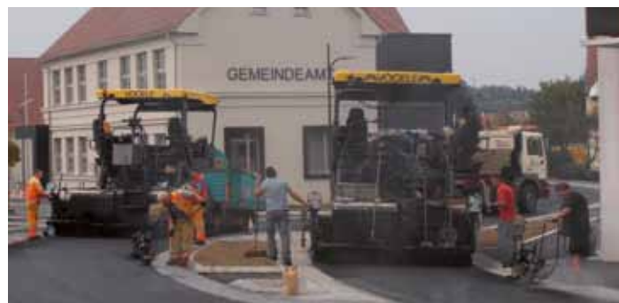
Beginn der Arbeiten im Bereich des Dorfplatzes: Die Fahrbahn wurde verbreitert, durchgehend eine neue Entwässerungsleitung verlegt.
