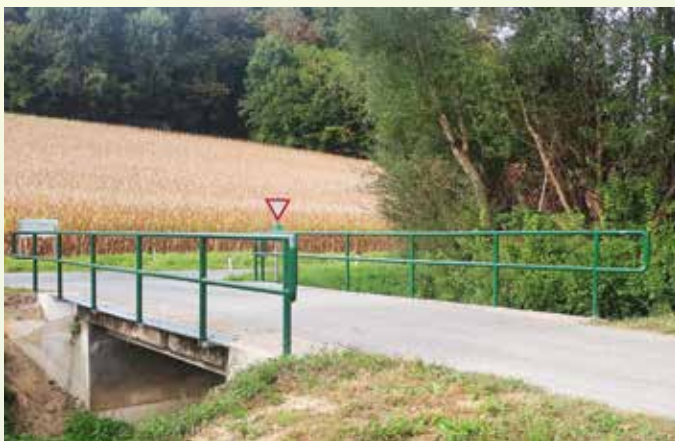
Die „Dornegg-Brücke“ wurde fachgerecht saniert.
