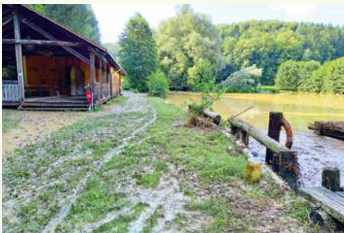
Schwere Unwetterschäden beim Fischteich in Stein
